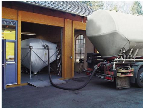
Bild 5: Die Lieferung der Pellets erfolgt in Tankwagen
